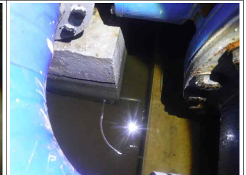
밸브 받침콘크리트 상태
